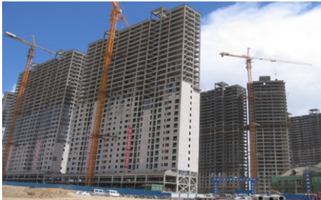
图2为正在建设中的万郡·大都城。
