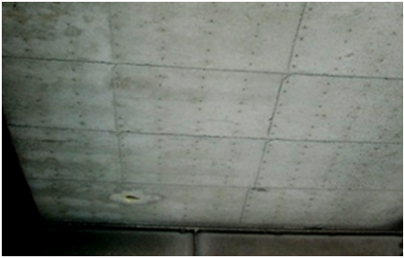
图3 装配式钢筋桁架楼承板
