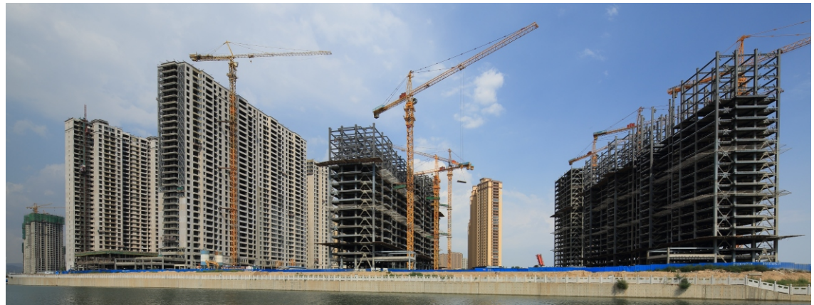
杭萧钢构施工现场
