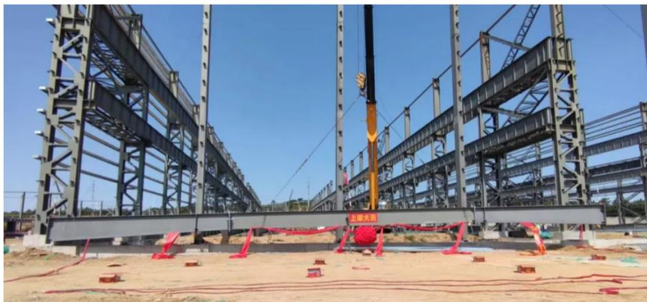
7月初，由杭萧钢构（山东）有限公司（以下简称山东杭萧）承建的山东新船海工装备有限公司4.5万吨高端海工装备配件生产项目钢结构顺利完成首榀屋架梁吊装，标志着该项目钢结构施工进入全新阶段。
